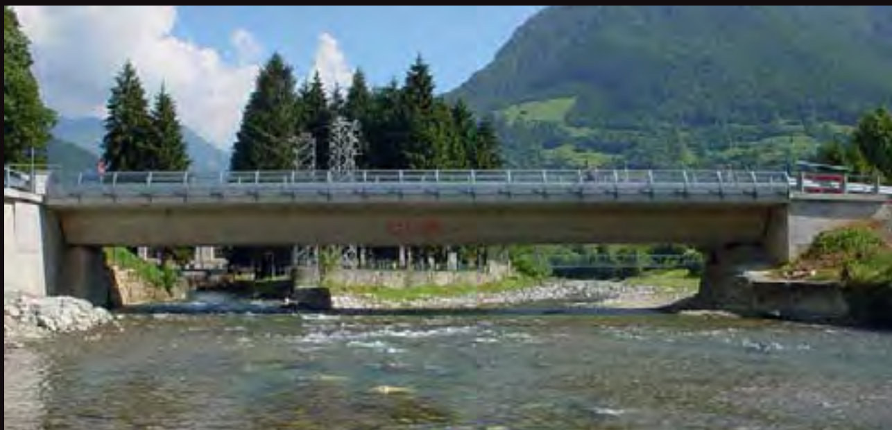
Ardesio ponte stradale
