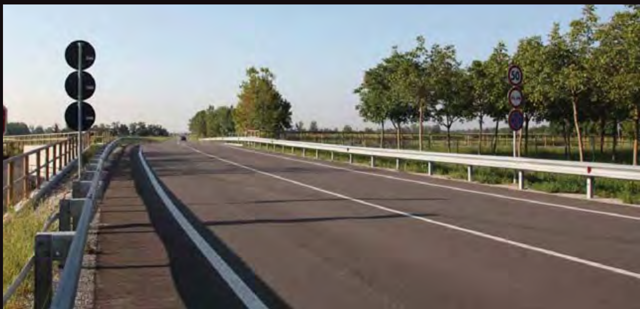
Bolgare - Palosco tangenziale di collegamento
