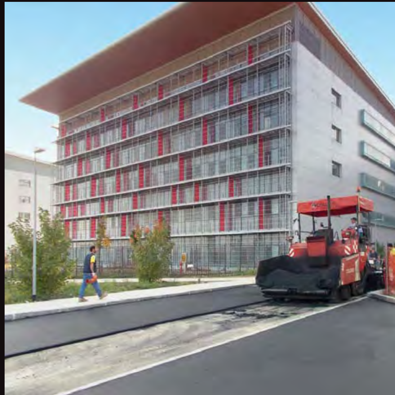
Bergamo asfaltatura nuovo ospedale
