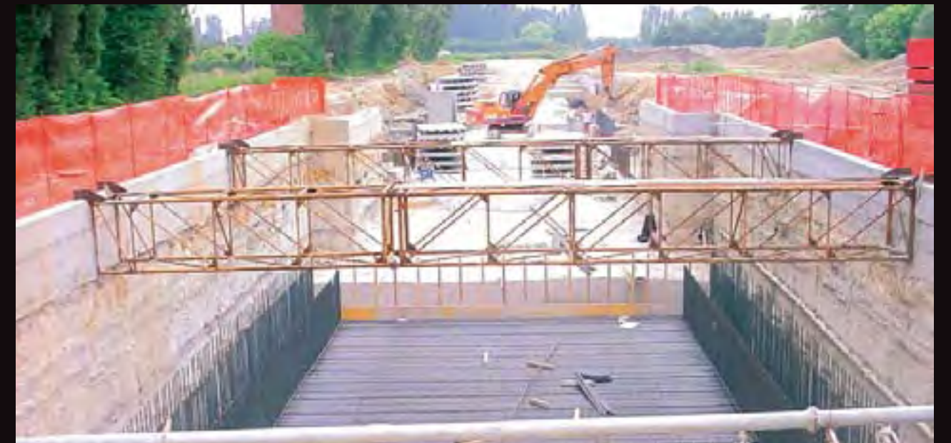
Mogliano sottopasso ferroviario
