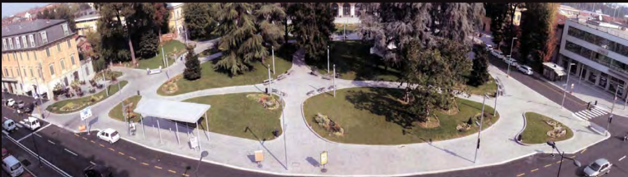
Cremona riqualificazione stazione ferroviaria
