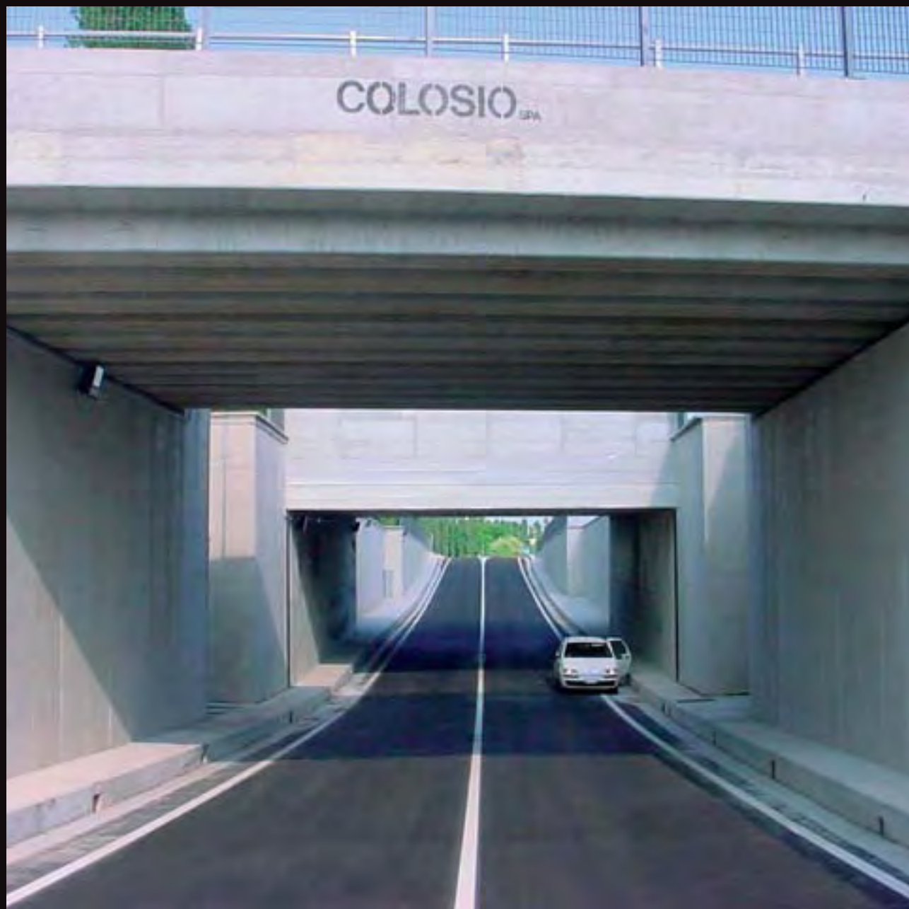
Mogliano sottopasso ferroviario
