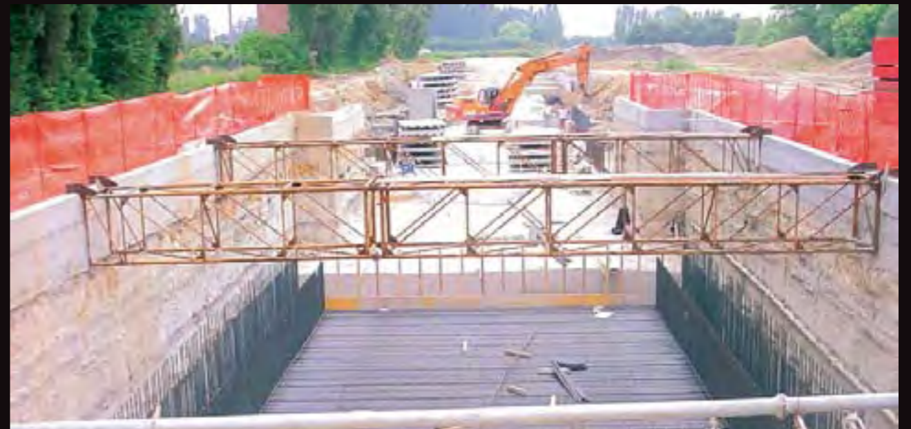
Mogliano sottopasso ferroviario
