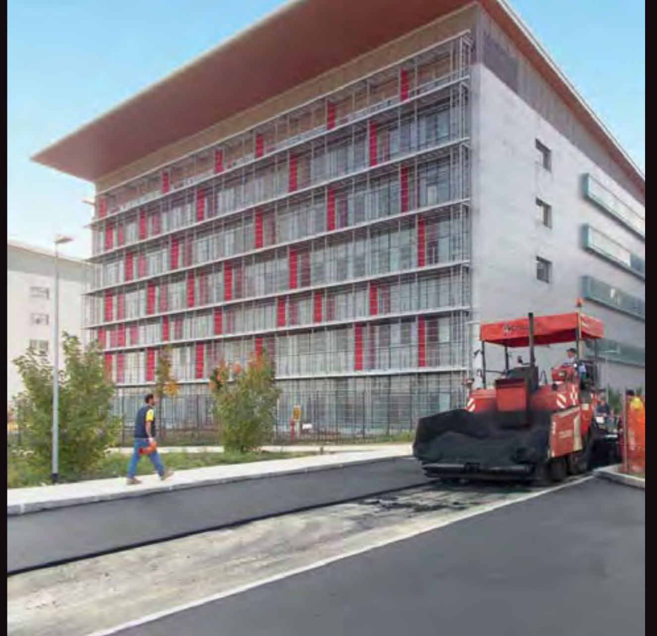
Bergamo asfaltatura nuovo ospedale
