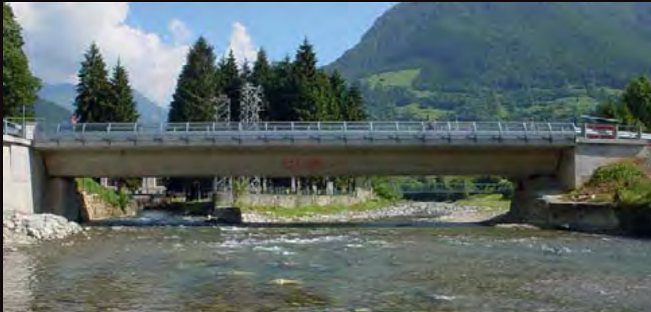
Ardesio ponte stradale
