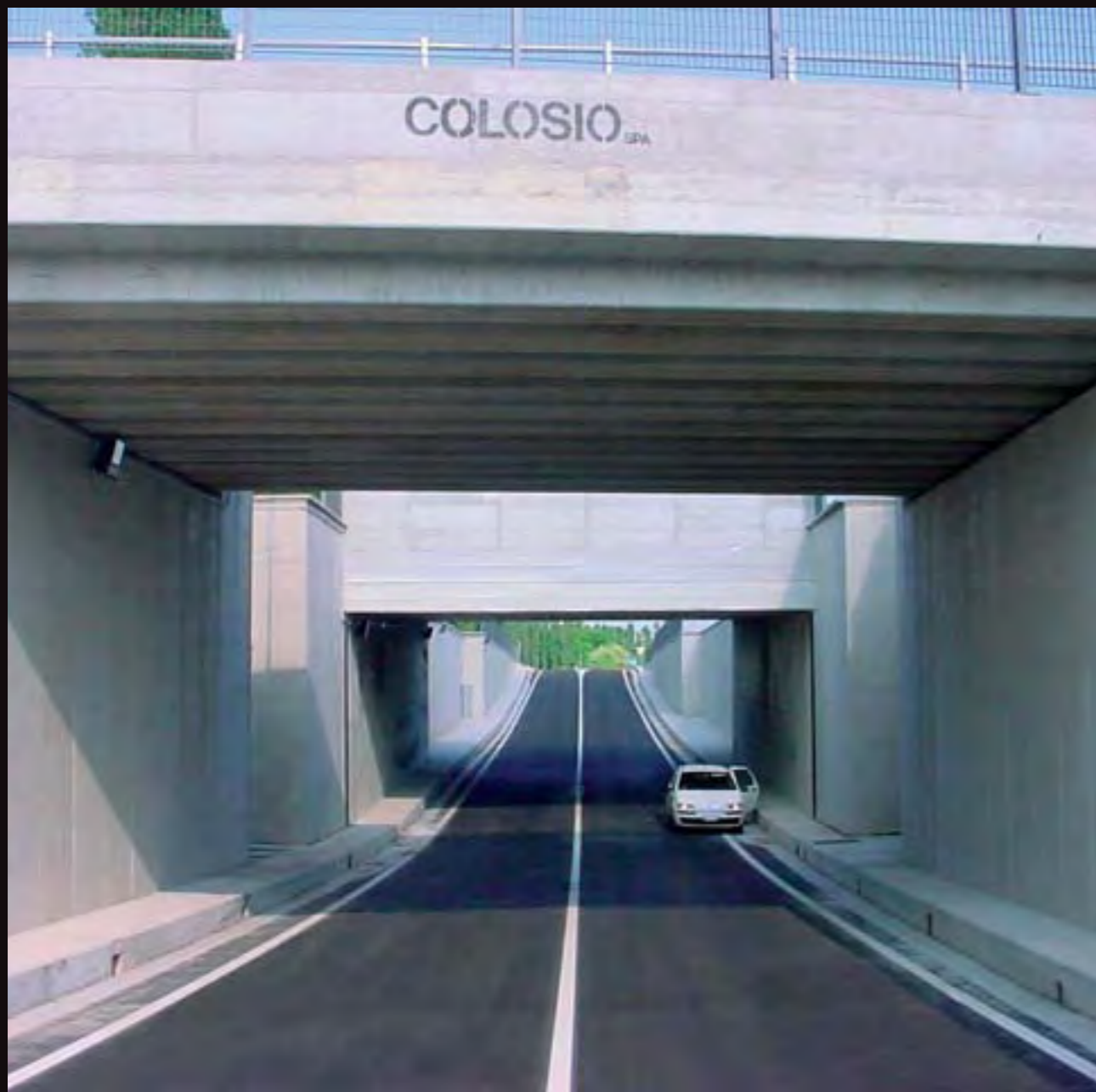
Mogliano sottopasso ferroviario
