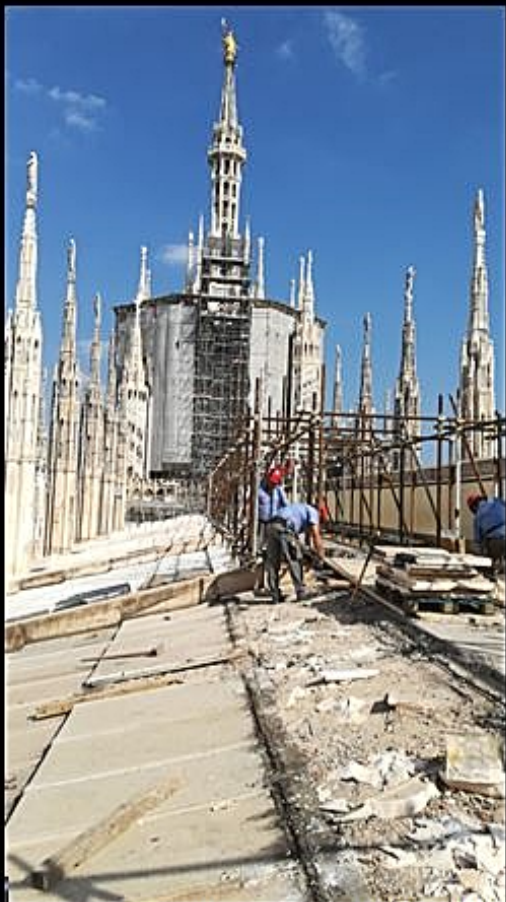
Duomo di Milano Rifacimento parziale copertura Tiburio e Terrazze
