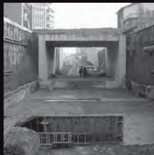
Cormano sottopasso ferroviario
