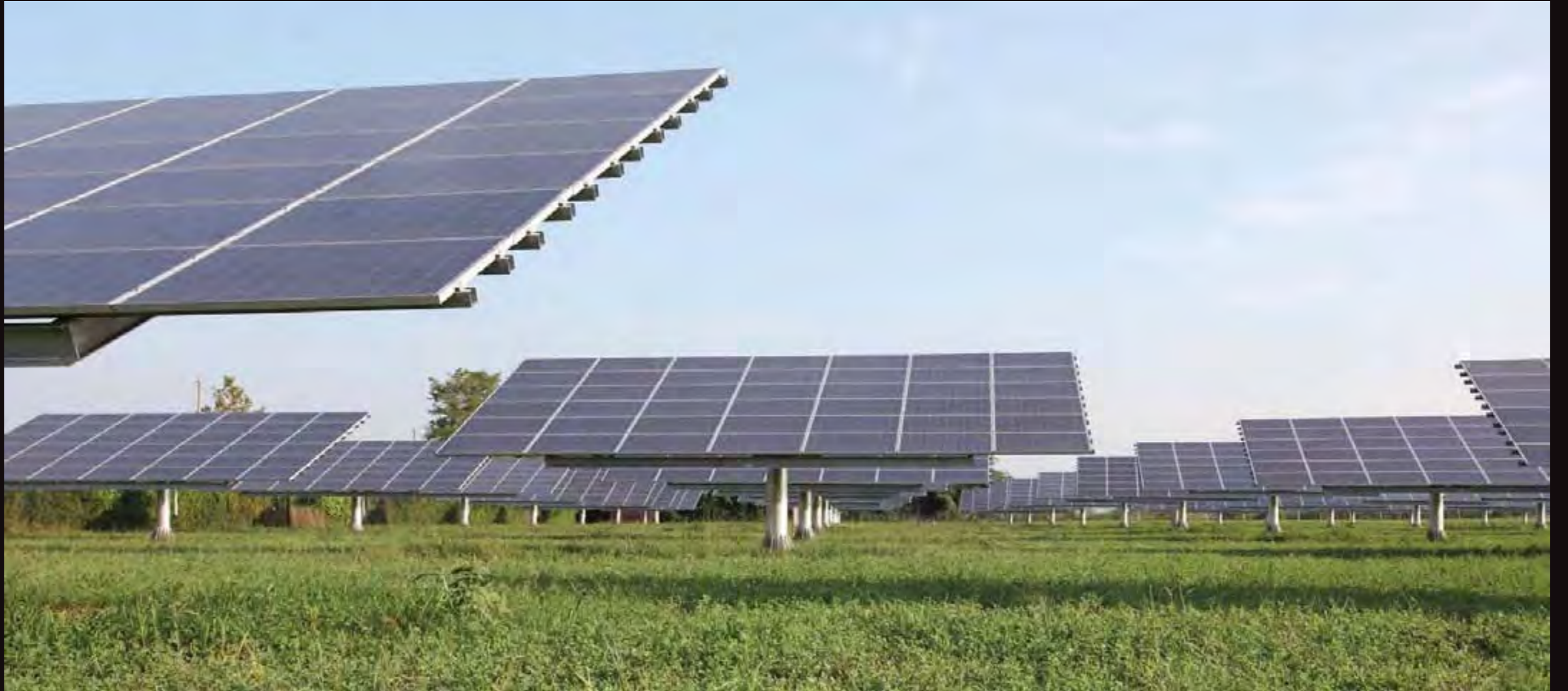
Spirano centrale fotovoltaica
