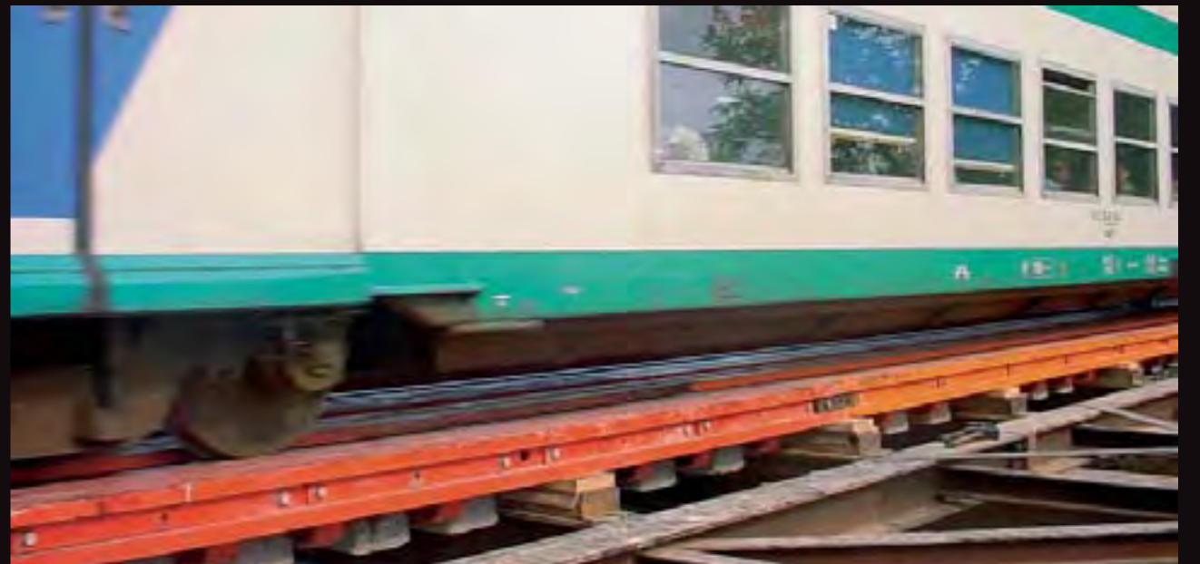
Mogliano sottopasso ferroviario
